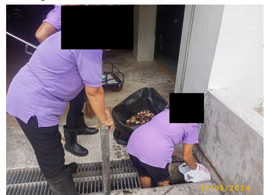
รูปที่ 41 การทำความสะอาดท่อระบายน้ำ
